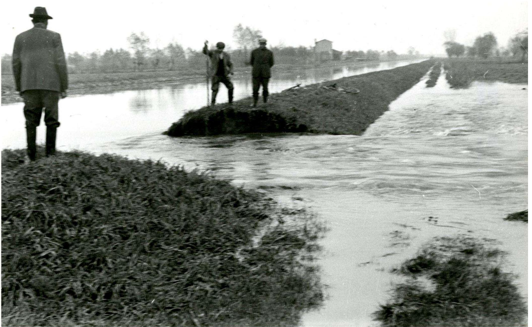
Rotta dell' Argine destro del canale di scarico dell'idrovora di S.
