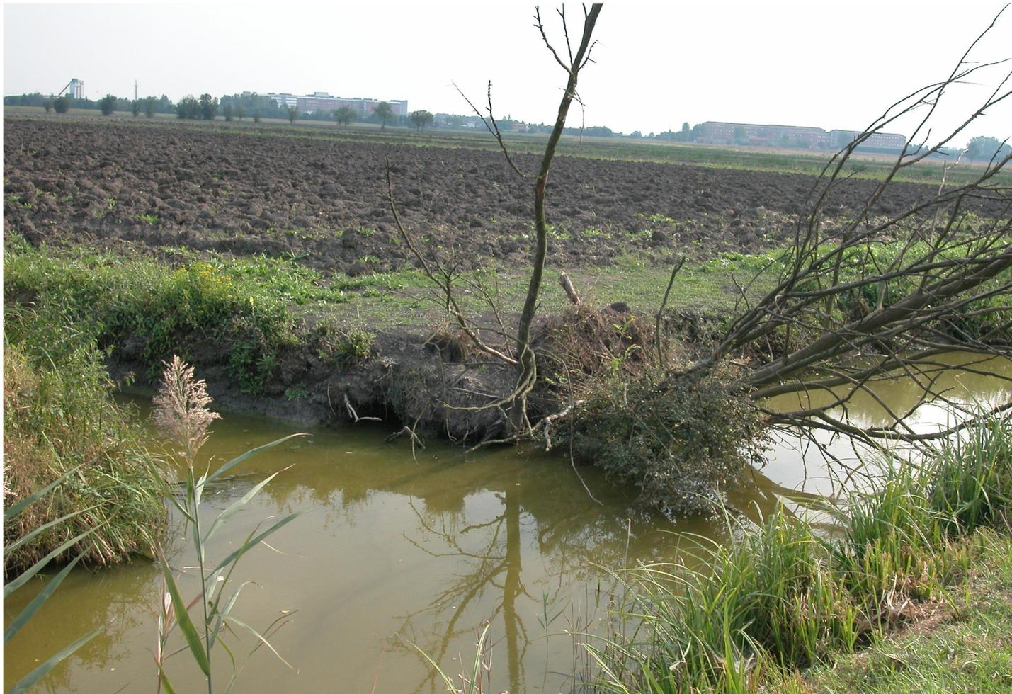
Smottamento delle scarpate causato dalla rosura da parte di nutria
