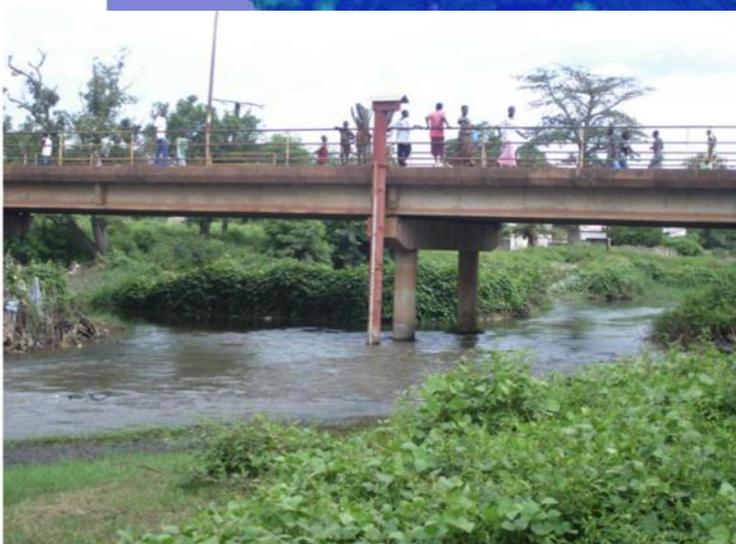
Strumento per la misurazione del livello dell'acqua presso Kolda, a 280 Km dalla foce.
