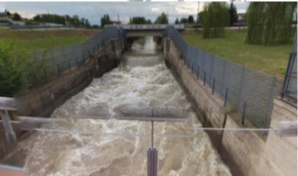
SALTO CORBOLONE per limitare portata verso valle favorendo invaso a monte: Q_{valle} < 120 \text{ m}^3/\text{s}
