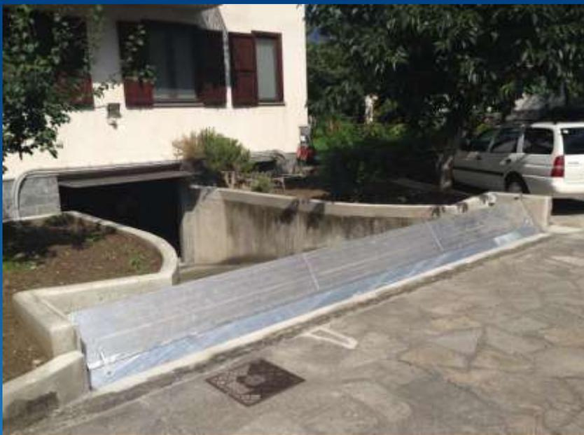
..... In tali situazioni, comunque, si ritiene necessaria la realizzazione di idonei interventi di impermeabilizzazione dei locali alle acque di falda, la protezione idraulica in corrispondenza degli accessi e la dotazione di sistemi autonomi di sollevamento delle acque fino ad una opportuna quota di sicurezza al di sopra del piano stradale.
