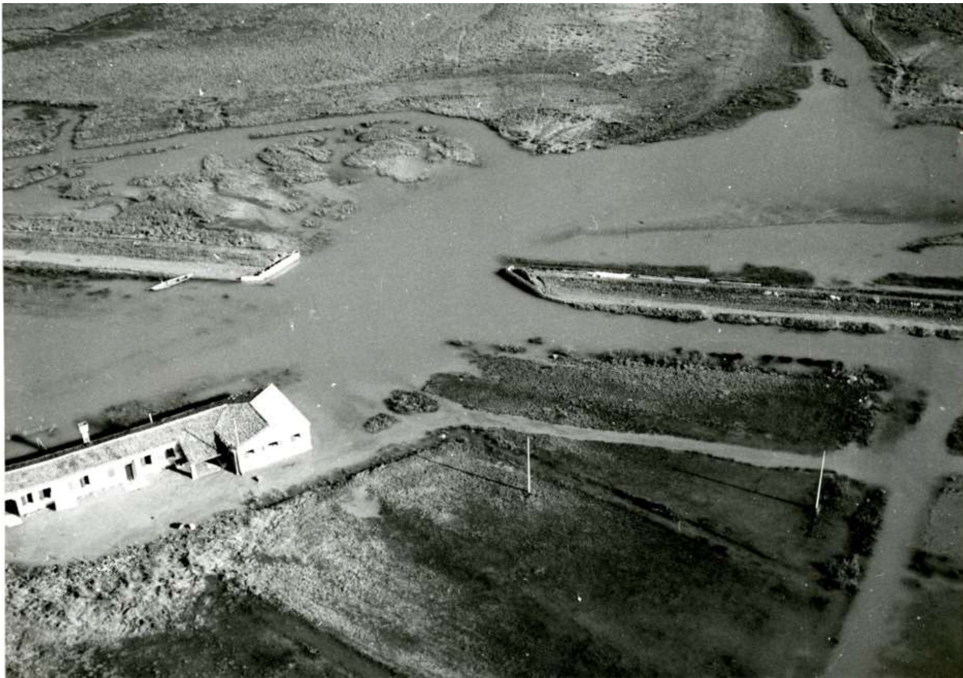
Rotta argine di conterminazione lagunare in località Trezze (Chioggia)
