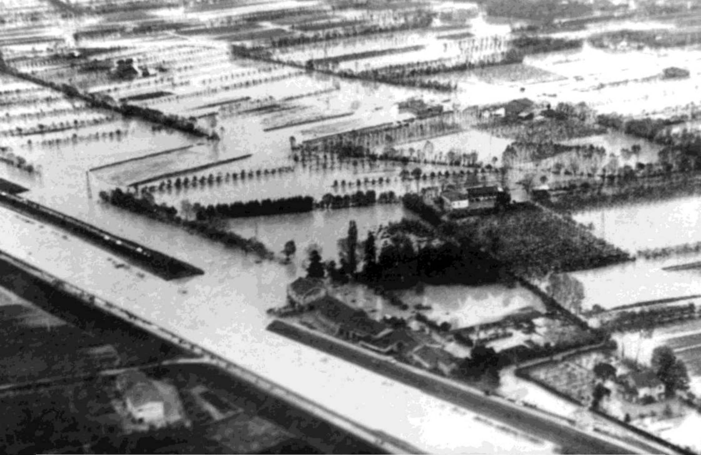
Rotta argine destro del Piovego a Noventa Padovana
