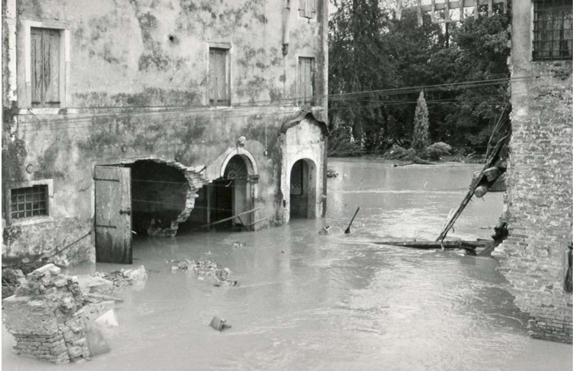
Falla argine destro del Canale Piovego (all'altezza di Villa Gemma a Noventa Padovana)
