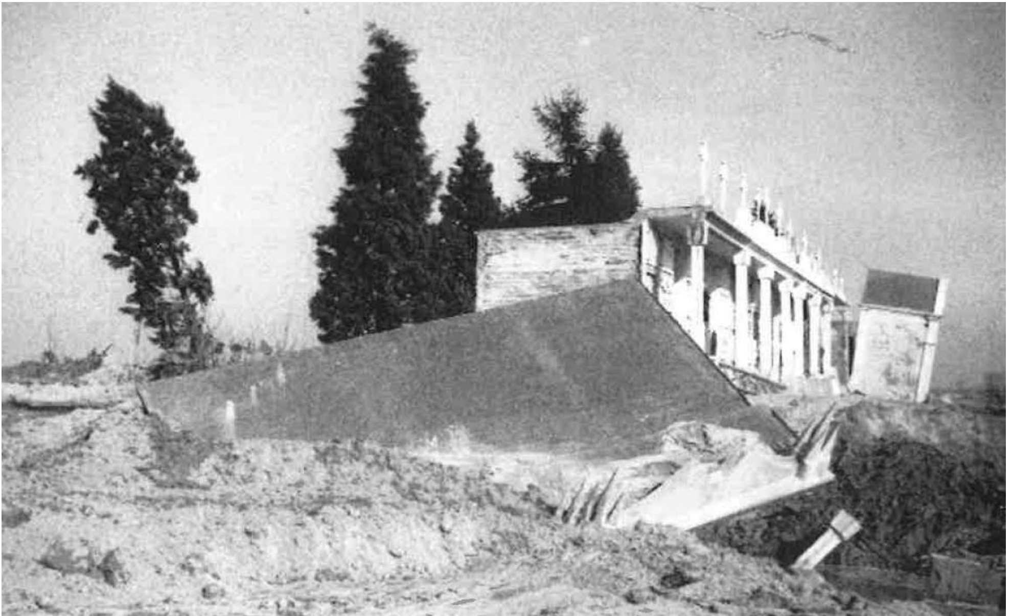
Il cimitero di Conche di Codevigo invaso dalle acque a seguito della rotta dell'argine sinistro del fiume Brenta
