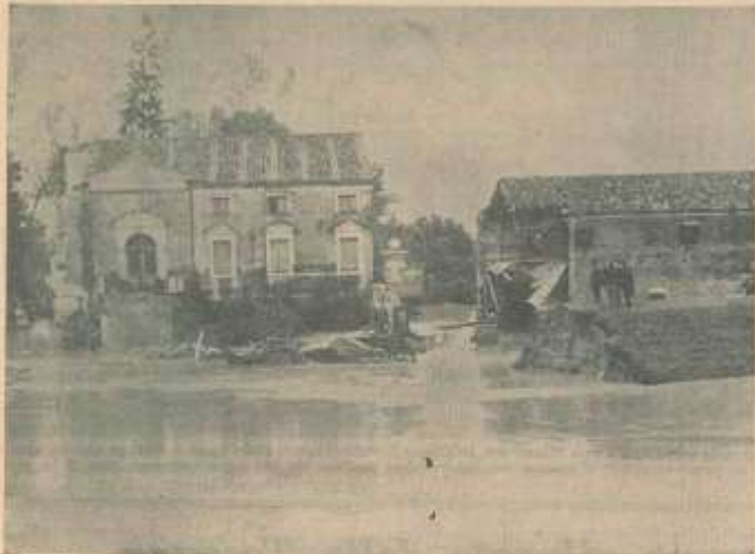
La falla aperta nell'argine destro del Canale Piovego all'altezza della settecentesca Villa Gemma che ha subito gravissimi danni.
