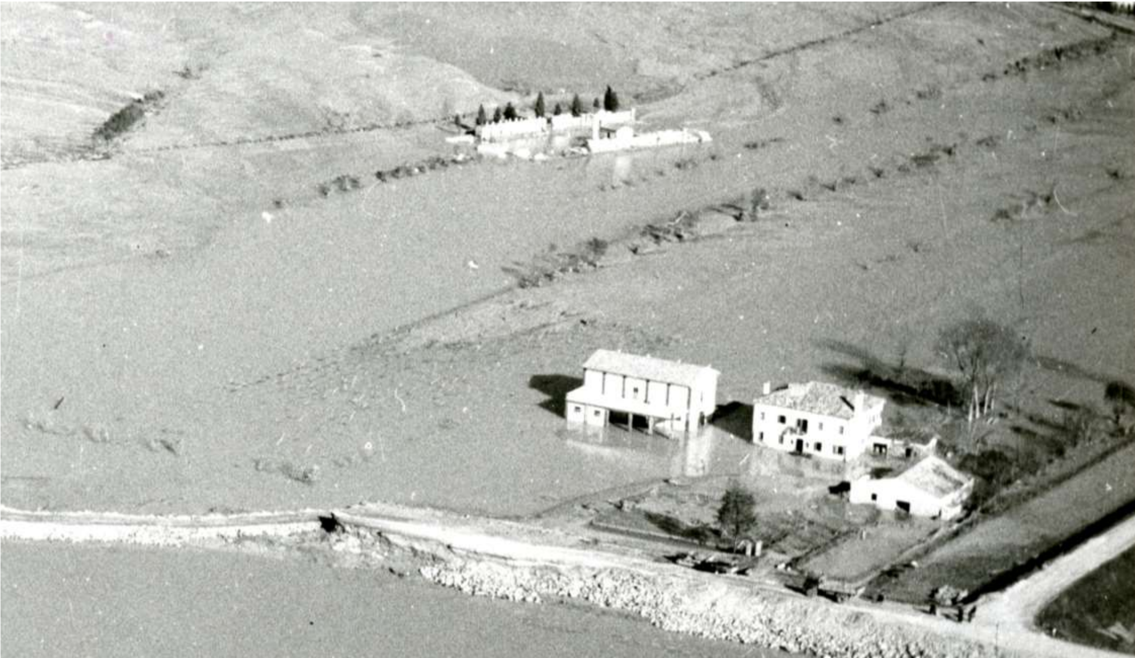
Rotta argine sinistro fiume Brenta a Conche di Codevigo. Sullo sfondo il cimitero di Conche
